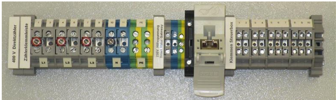
Abbildung 3: Zählerklemmleiste Direkte Messung 400 V
